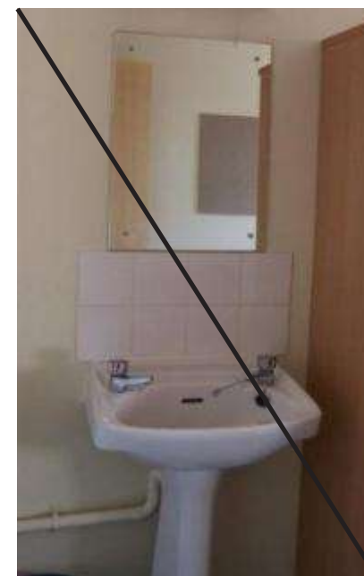
Плохо Раковина с пьедесталом. Фартук из плитки
